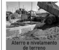
Aterro e nivelamento de terreno
