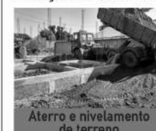
Aterro e nivelamento de terreno
