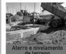
Aterro e nivelamento de terreno
