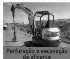
Perfuração e escavação de alicerce
