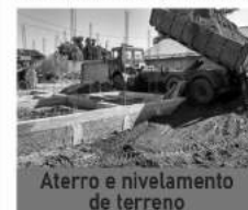
Aterro e nivelamento de terreno
