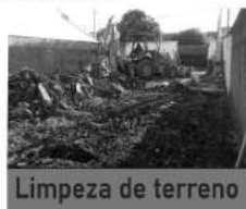
Limpeza de terreno
