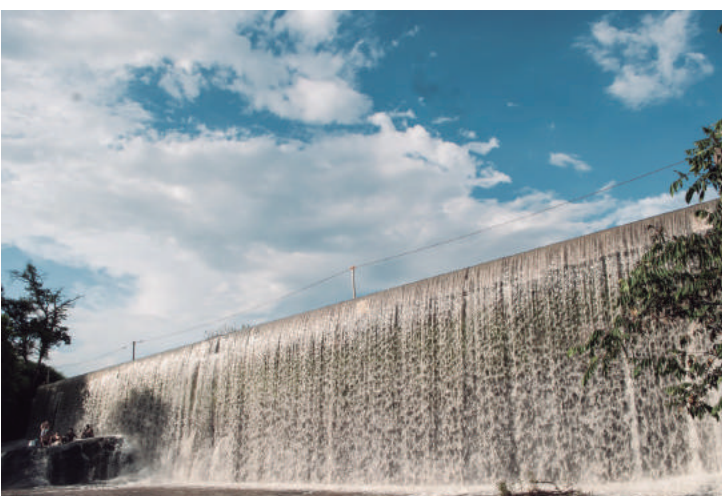
Represa e Paredão - Usina Ester
