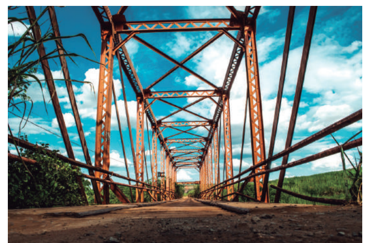
Ponte de Ferro
