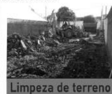
Limpeza de terreno
