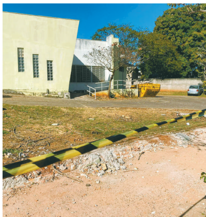
UBS do bairro Beto Spana está em reforma
