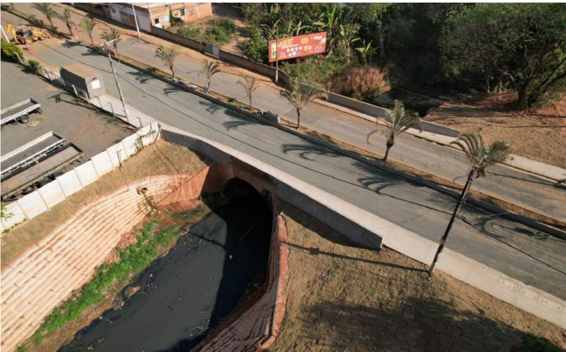
Reconstrução da Ponte do Baguá sobre o Rio Jaguari
