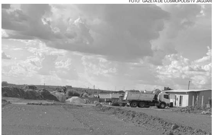
Canteiro de obras da CDHU
