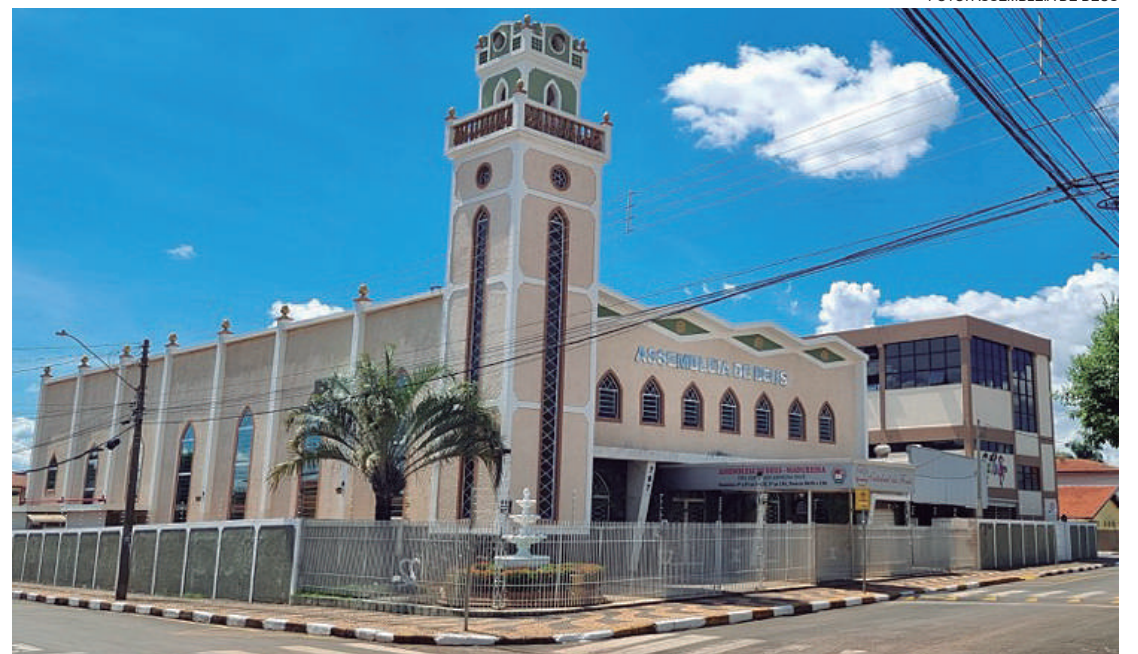
Construção da Igreja Assembléia de Deus teve início no ano de 1982, na rua Dr. Moacir do Amaral em Cosmópolis
